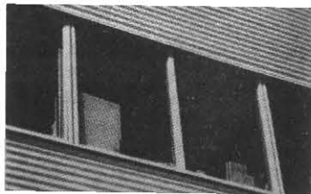
图1 PVC材料挥发物导致玻璃偏振光现象
