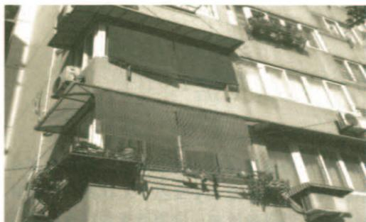
图1 居民自发安装的简易遮阳棚
